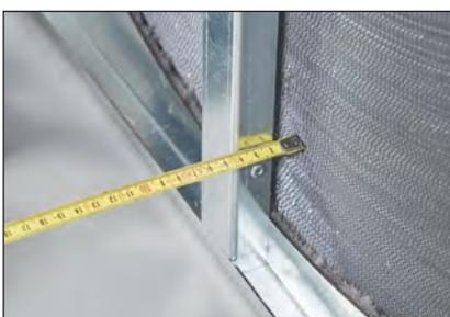
Compruebe el centrado de la rueda de calor en el centro vertical de la carcasa, midiendo los puntos ver (9) en ambos lados.
