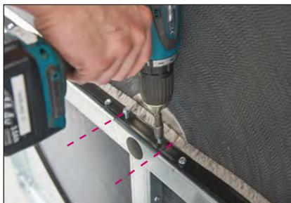
(4) Corte la junta de la escobilla como se indica en la imagen y afloje los tornillos de fijación de la tapa de los rodamientos
