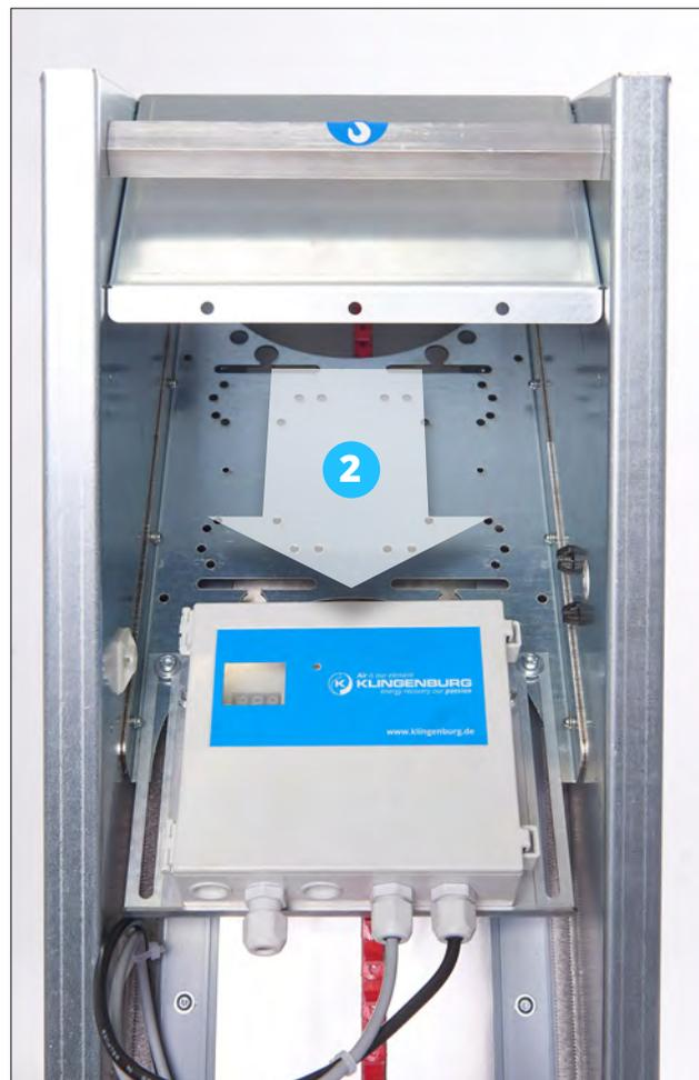
Fig. 14: Mueva la placa hacia abajo 2
