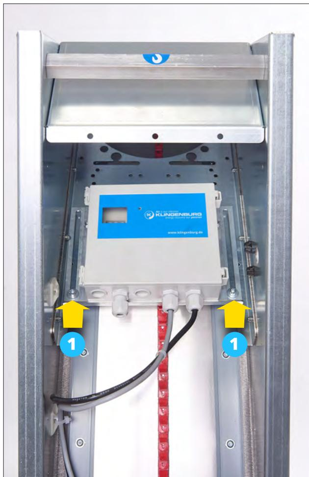
Fig. 13: Afloje la extracción del controlador 1
