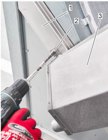
Abbildung 53: Montage der Auffangschale
